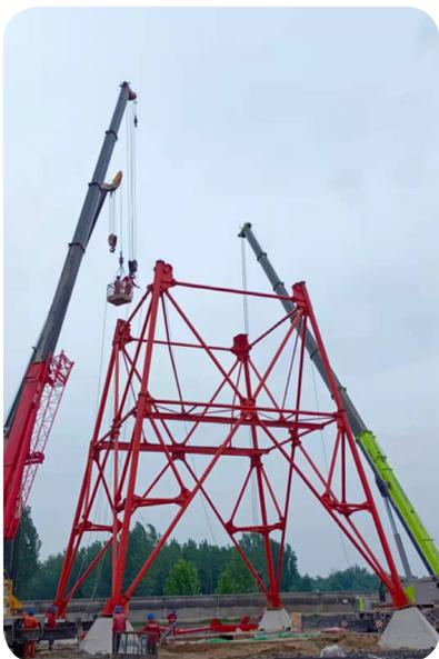
7月20日，阳城2号井混合井冻结正式开机，21日，风井凿井井架开始起立安装。
